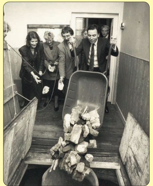
> Minister Elco Brinkman start de restauratie van het Remonstrantse hofje door het leegkiepen van de kruiwagen (1988)
