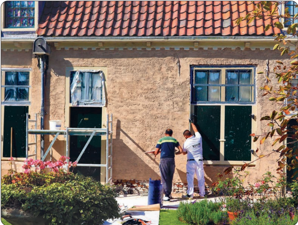
> De muren werden viermaal met kalkmortel gestukadoord
