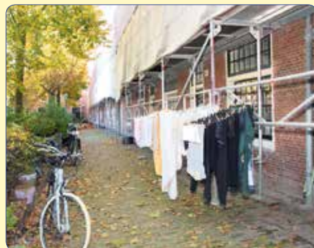
> Gevelonderhoud aan de zuidkant
